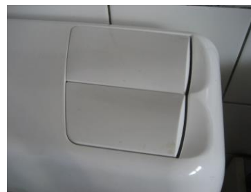
utiliser une chasse d'eau double
